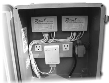
**Figura 4.57. Conexión del Módulo de riego Rain8 al módulo de interfaz bidireccional X-10.**
