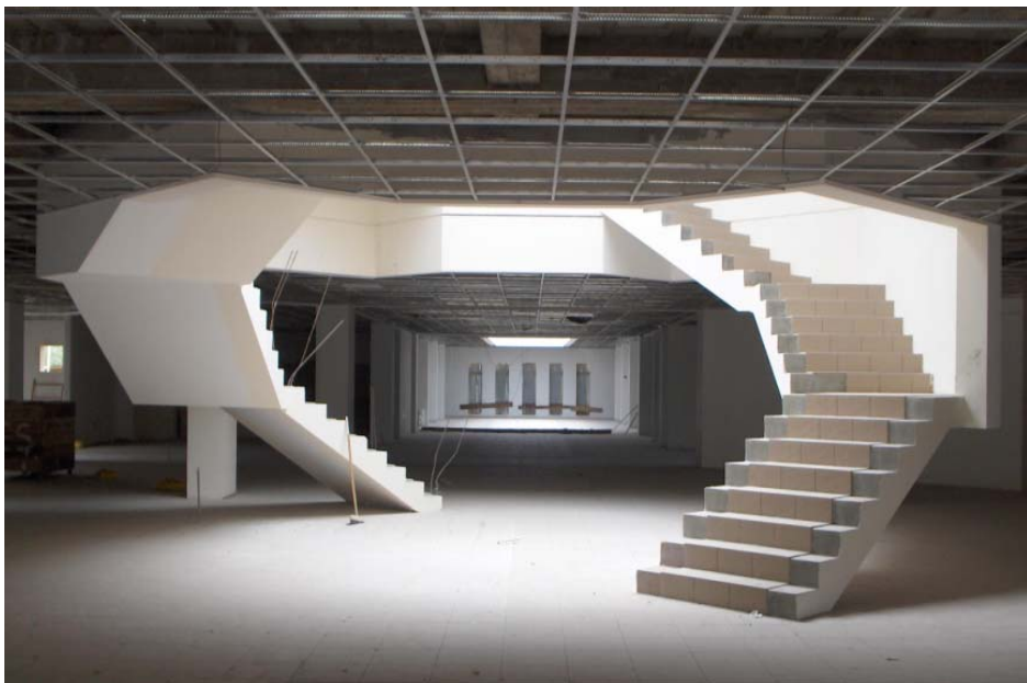
FIGURA 2.2 VISTA INTERIOR DEL EDIFICIO AUN EN CONSTRUCCIÓN
