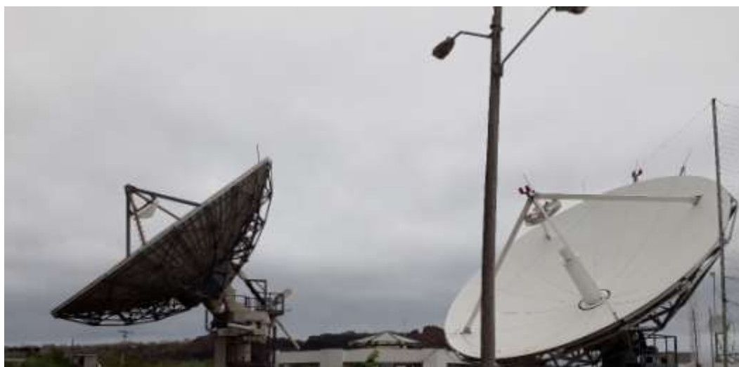
Figura A3: Antenas parabólicas de enlace satelital en la estación terrestre de las islas Galápagos.
