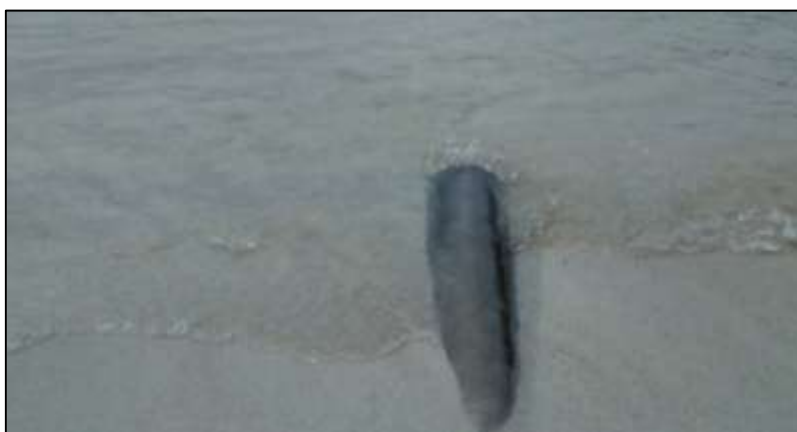
Figura 4.18: Tuberías en la playa Los Alemanes.
