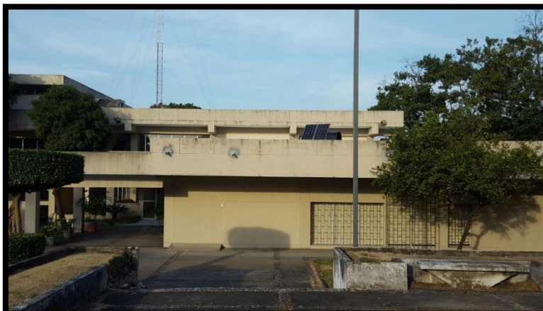
Figura 3.24: Instalación de los paneles fotovoltaicos
