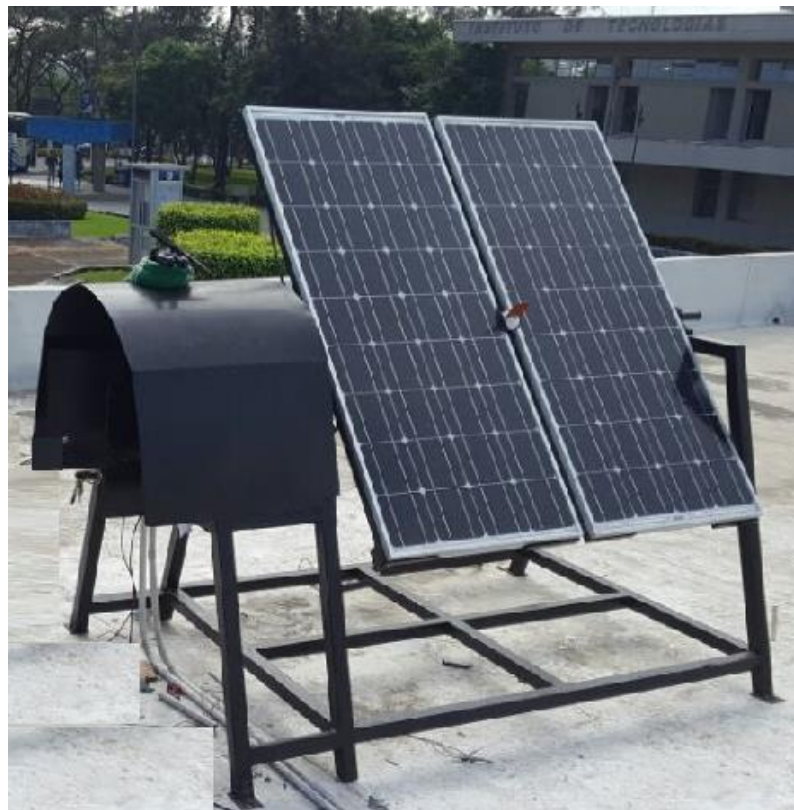
Figura 4.1: Estructura metálica instalada con paneles en el CIDIS.
