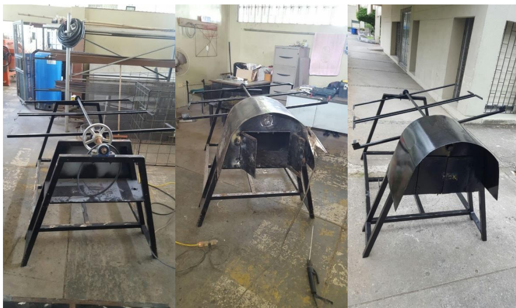
Figura 3.4: Proceso de construcción de la etapa mecánica
