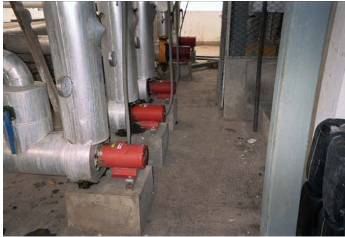
FIGURA 2.6 CIRCUITO PRIMARIO DE BOMBAS
