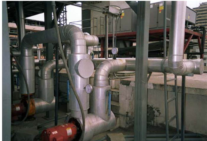
FIGURA 2.7 CIRCUITO SECUNDARIO DE BOMBAS
