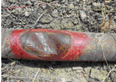
Figura 28 Pozo Tig. 1253 tramo 78 TIPO: Sumidura SECCION: D Tmm: 0.175" PROFUNDIDAD: 0.71"
