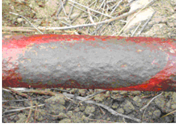
Figura 20 Pozo Tig. 18 tramo 145 TIPO: Corrosión externa SECCION: D Tmm: 0.176" PROFUNDIDAD: 0.021"
