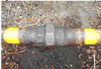
Figura 21 Pozo Tig. 20 tramo 268 TIPO: Fuga en brida ACCION: Reparar
