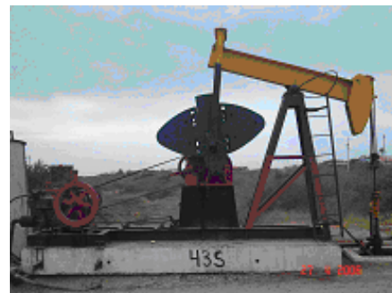
Figura 1.- Levantamiento Artificial por bombeo mecánico.
