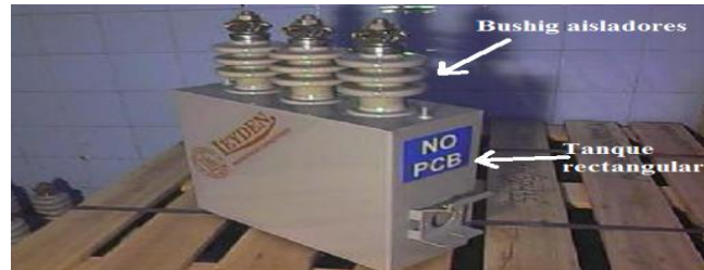
Figura 70: En la fotografía se muestran Capacitor trifásico con sus partes externas tomado del catálogo de LEYDEN.
