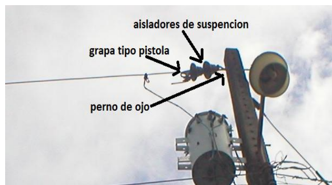
Figura 45: Estructura monofásica retenida con su respectivos elementos.
