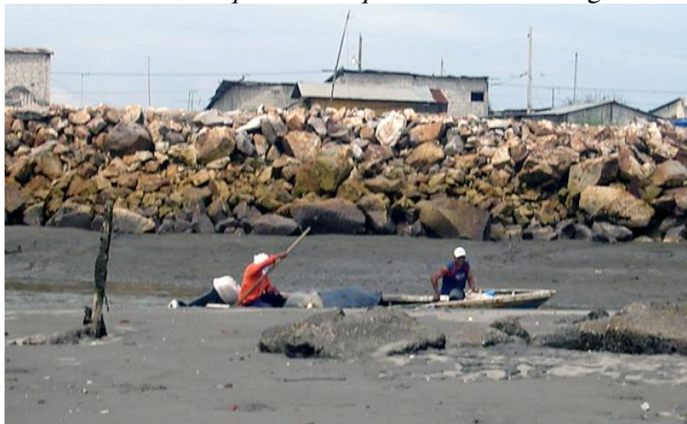
Foto 3 Avance de pescadores por el canal de navegación
