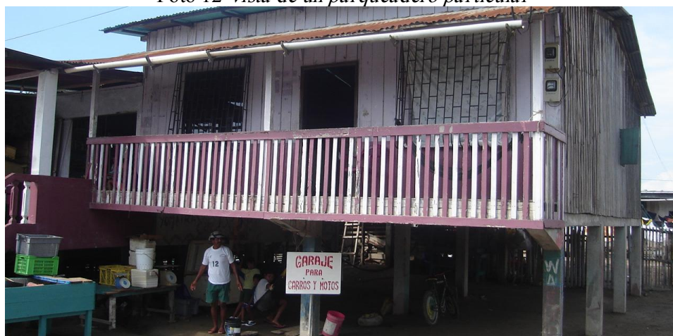
Foto 12 Vista de un parqueadero particular
