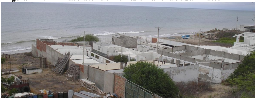
Figura # 11. Laboratorio en ruinas en la zona de San Mateo
