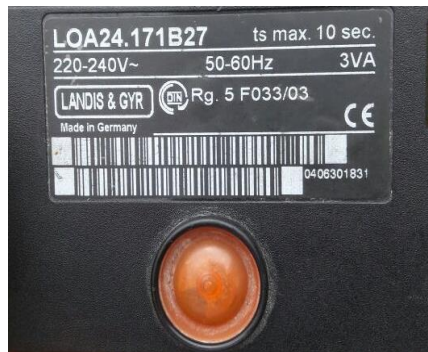
Figura 1.16 Controlador de llama para diésel. [Espol, 2018]
