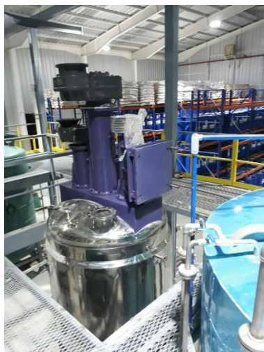
Figura 23 Montaje de tanque en plataforma
