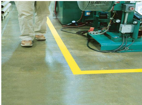
Figura 16 Señalización de pisos
