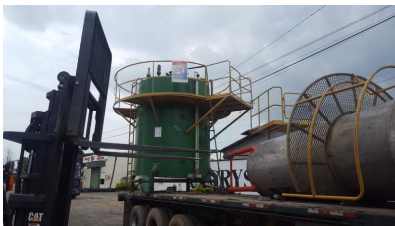
Figura 18 Desmontaje y traslado de equipo
