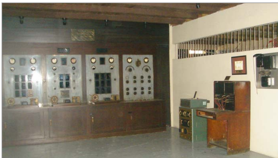
Figura N° 21 Central de Alarma, Museo del Bombero Fuente: Elaboración propia
