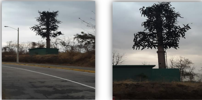
Figura 6 Antena mimetizada ubicada en ESPOL, campus Prosperina.
