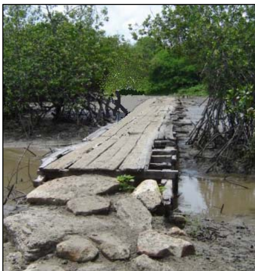
Figura 13: Puentes de madera Fuente: Autoras (2006)
