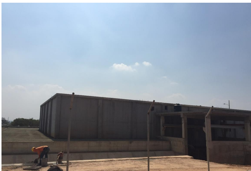
Figura 2. 7 Nuevo reservorio “Peñón del río” en construcción
