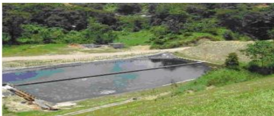
Figura 4.14 Vista de lixiviado producido por relleno sanitario
