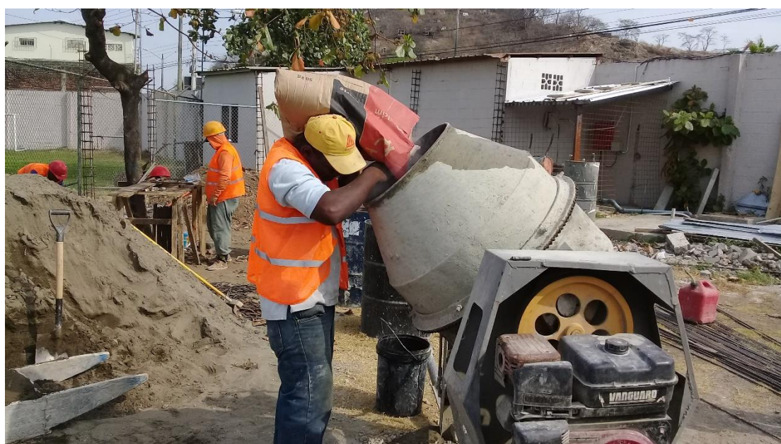
Figura 3. 43 Vertido de cemento portland en concreteira.
