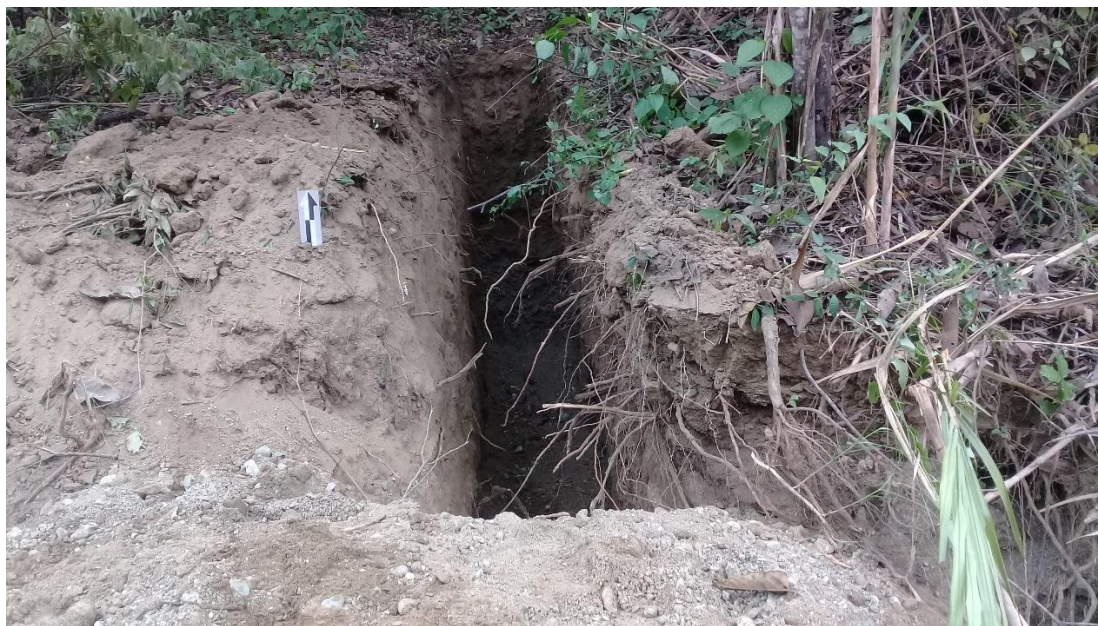
Figura 3. 16 Calicata hecha con retroexcavadora.
