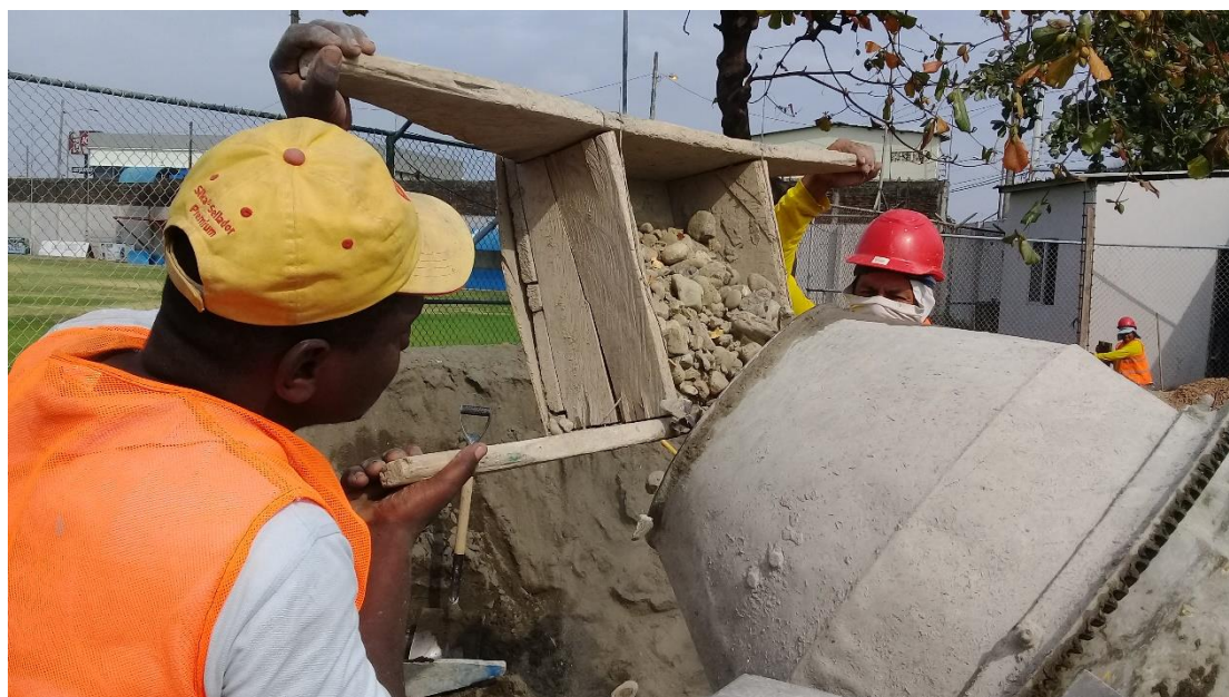
Figura 3. 42 Vertido de agregado grueso en concreteira.
