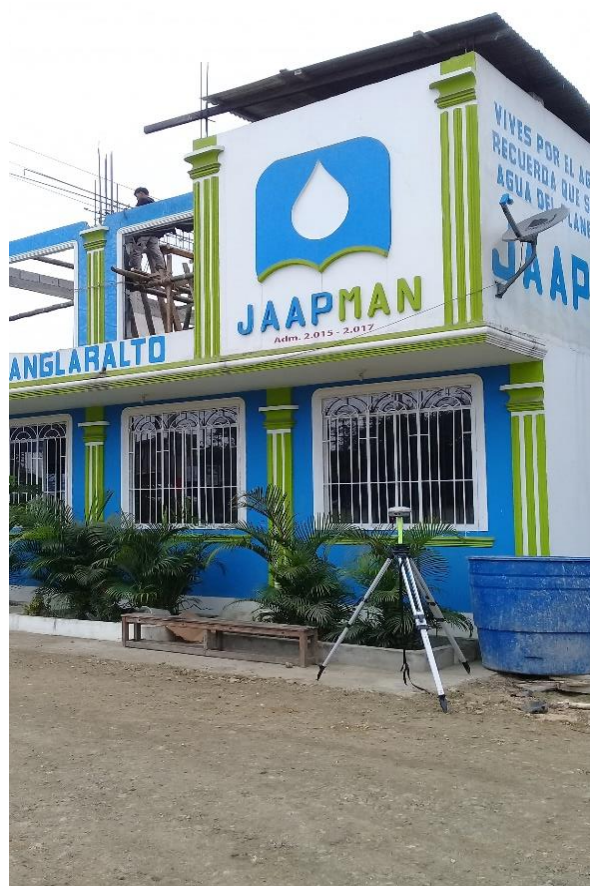
Figura 3. 1 Junta de Agua Potable de Manglaralto (JAAPMAN)
