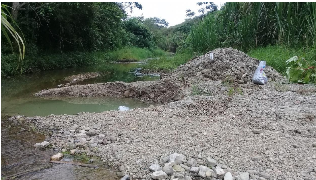
Figura 3. 21 Excavación hecha en el río.
