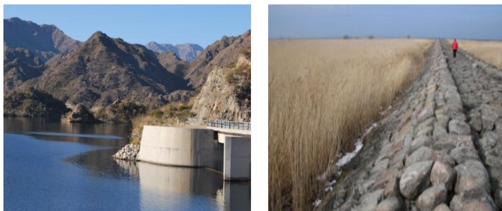
Figura 2. 5 Ejemplo de diques.
