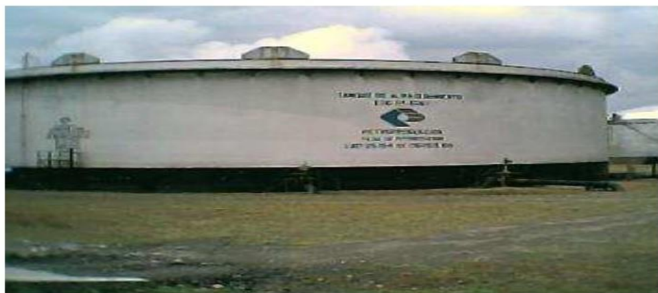
Figura 1.7 Tanque de oleoducto
