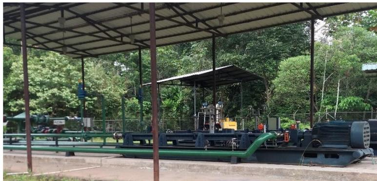
**Figura 1.14 Bombas HPS, parte del sistema de reinyección**
