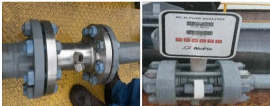
**Figura 1.31 Medidor de turbina (Izq.) Analizador MCII, acoplado a la turbina**
