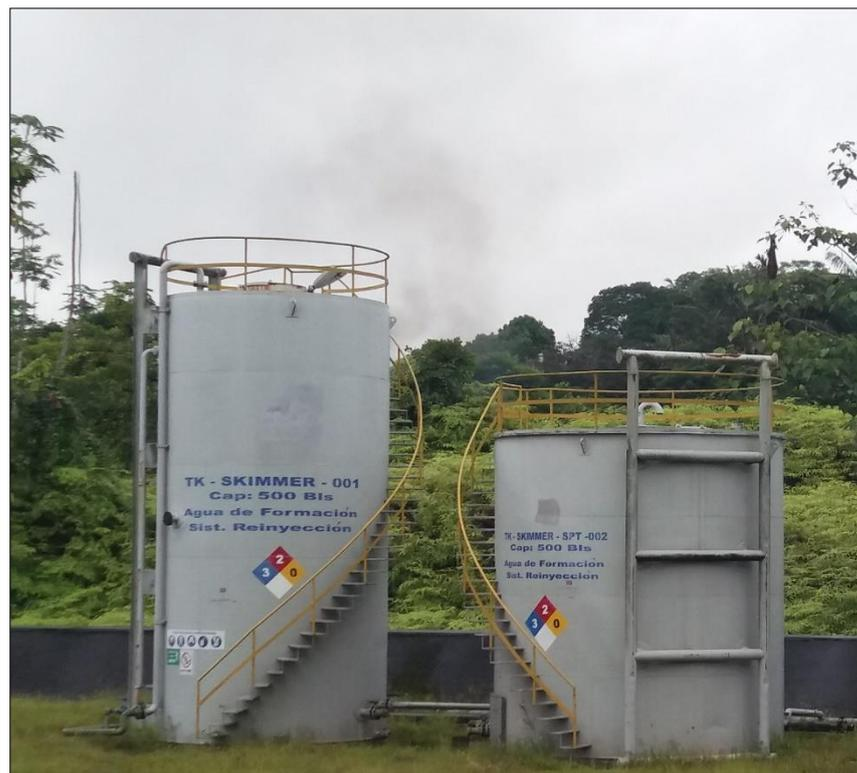
**Figura 1.27 Tanques de reinyección de agua de formación**
