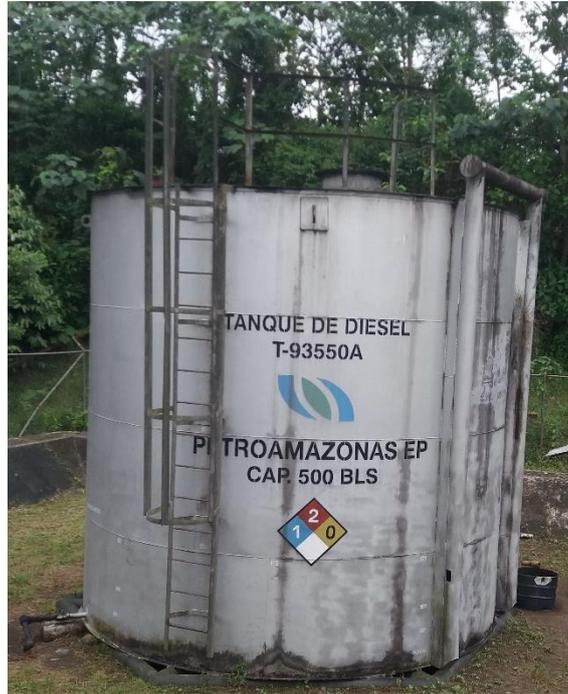
**Figura 1.23 Tanque de almacenamiento de diésel**
