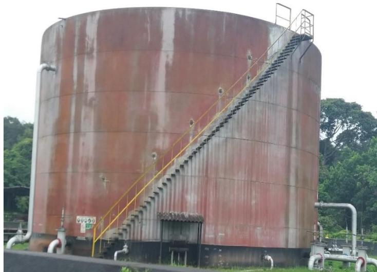
**Figura 1.11 Tanque de surgencia usado como tanque de lavado**
