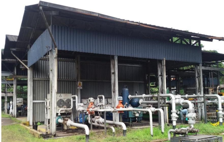
**Figura 1.22 sistema de transferencia de crudo**
