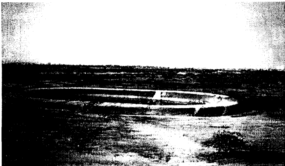
FIGURA 1.1. PISCINA DE TIERRA CUBIERTA CON LAINER
