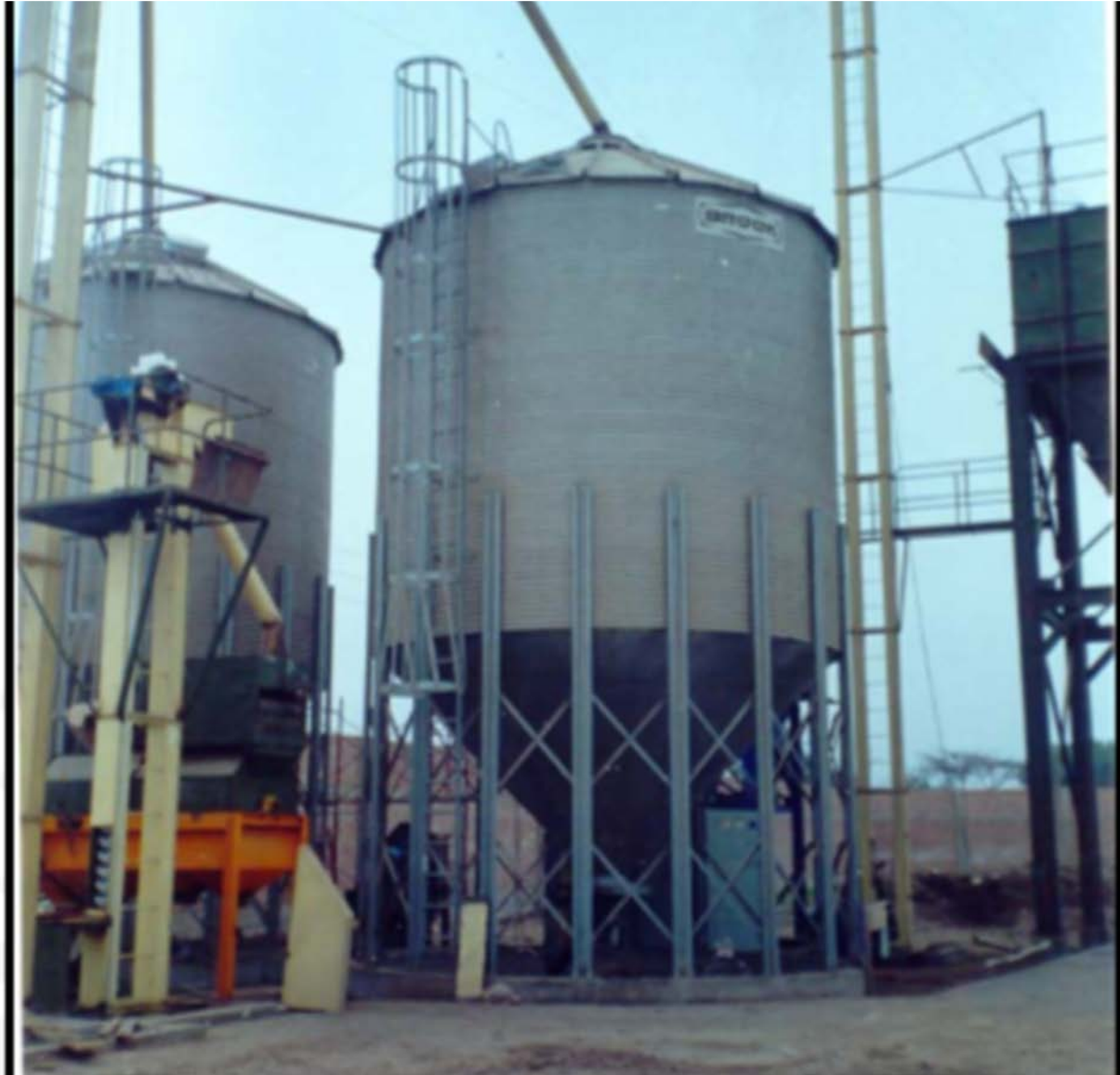
Ilustración 3-1. Silo cónico elevado para almacenar materias primas Fuente: (Salazar, 2008)
