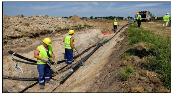
Figura 2.8 Transmisión de energía por medio subterráneo.
