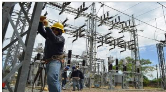
Figura 2.17 Subestación eléctrica Pasaje.
