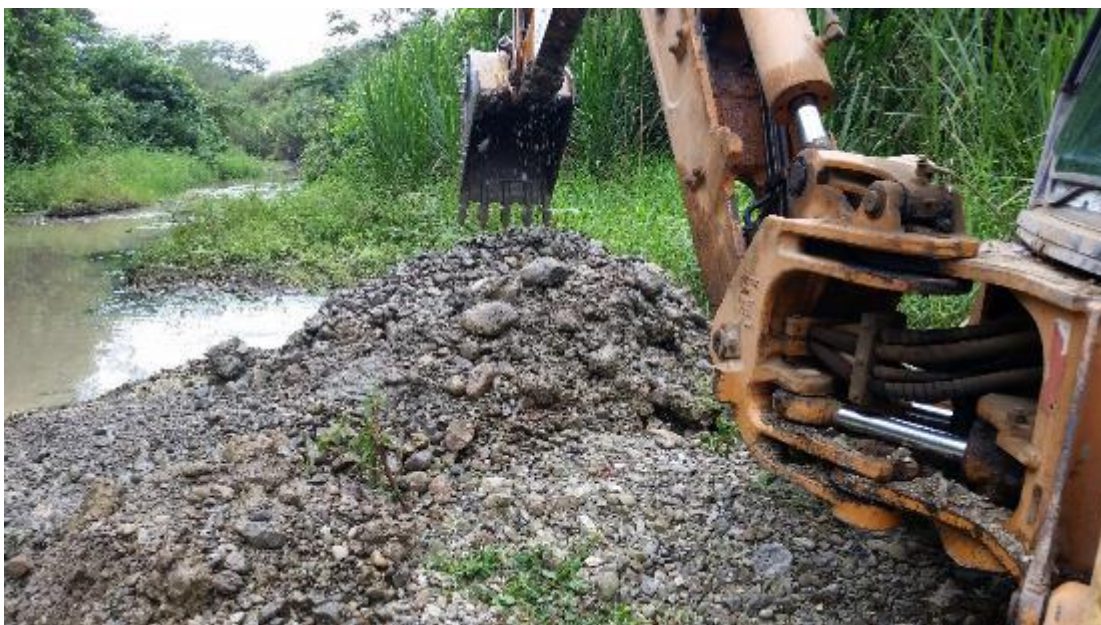
Figura 0.25. Excavación hecha en el río.
