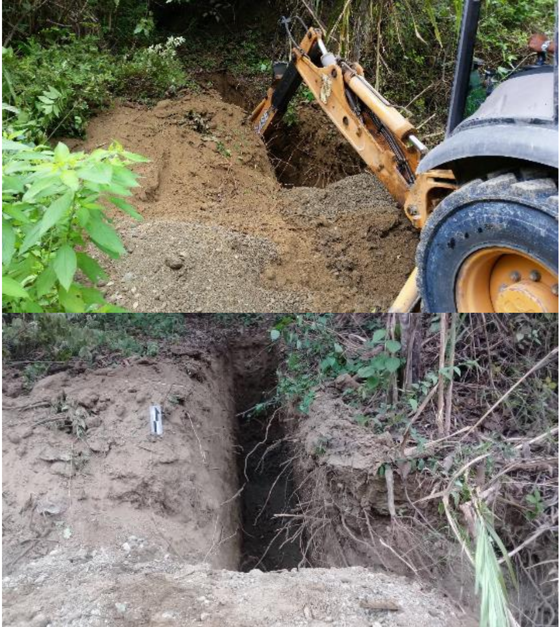
Figura 0.20. Calicata hecha con retroexcavadora.
