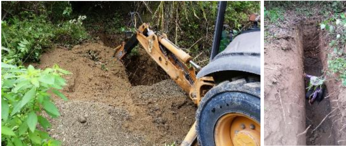
Figura 0.8. Calicata con maquinaria.
