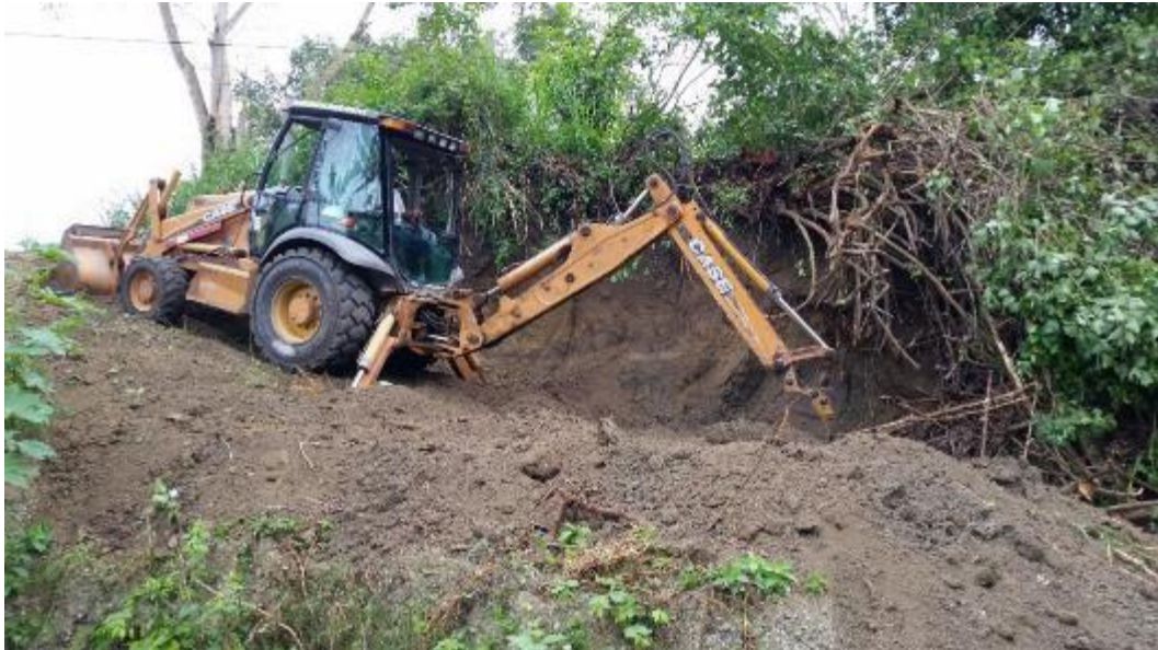
Figura 0.21. Corte de talud para toma de muestras.
