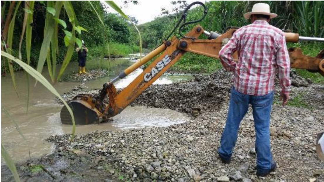
Figura 0.18. Toma de muestras a 2 metros de profundidad
