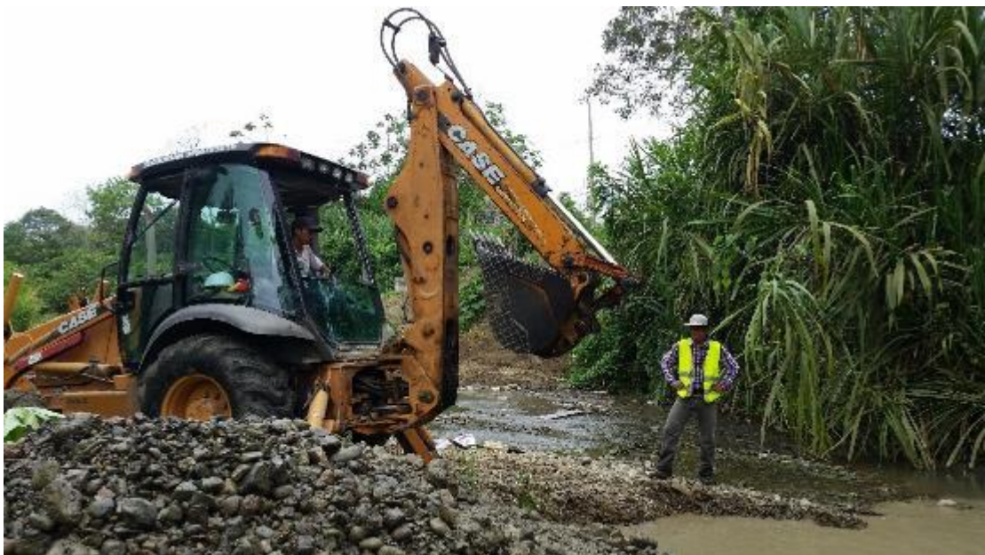
Figura 0.19. Toma de muestras con retroexcavadora en el cauce.
