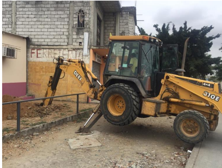
Figura 2.6 Excavación con retroexcavadora
