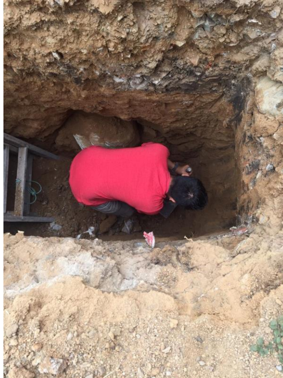
Figura 2.8 Colocación de tubo Shelby
