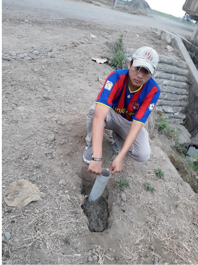
Anexo A1. Construcción de hitos temporales para georreferenciación.
