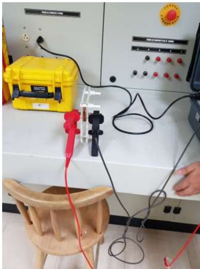
Anexo B3: Ensayos de resistencia eléctrica muestra MB Fuente: Ángel Pacalla y Adriana Vargas
