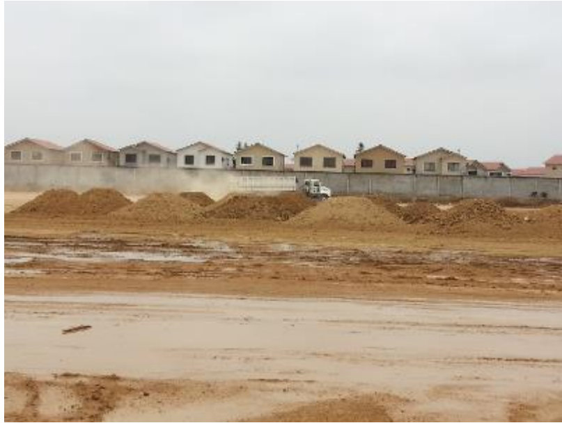
Figura 35. Ingreso de volqueta con material y dispersión de material particulado. Fuente Elaboración Autor
