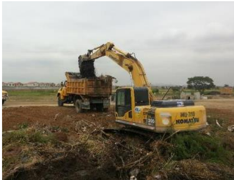
Figura 36. Retro de oruga, cargando material vegetal estoqueado para ser desalojado. Fuente Elaboración Autor
