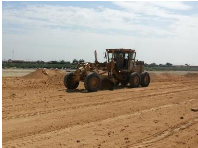
Figura 38. Nivelación de terreno con motoniveladora. Fuente Elaboración Autor
