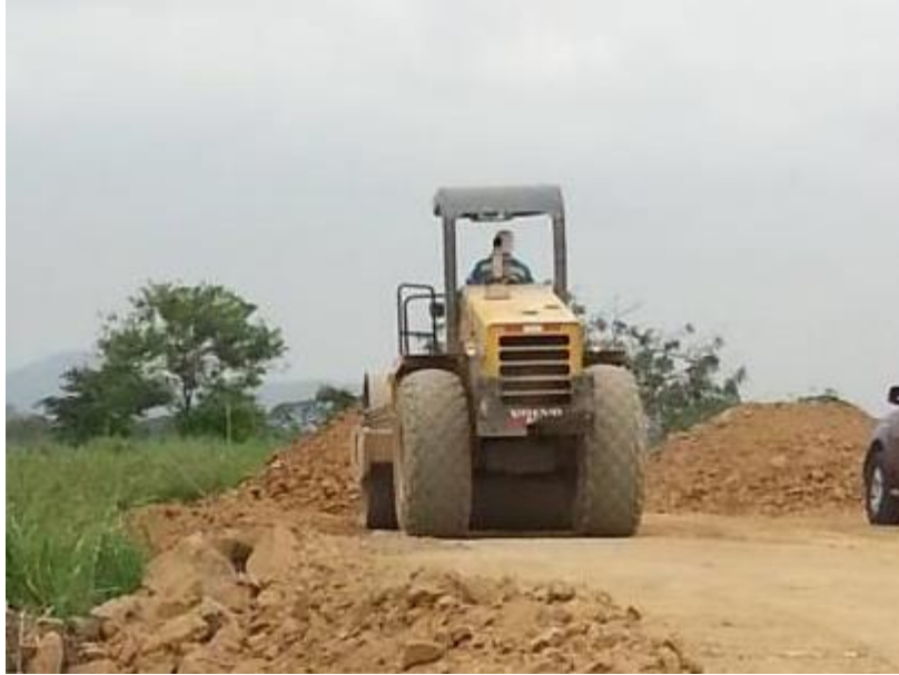
Figura 39. Compactación de terreno en capas de 0,40 m., altura; previa hidratación. Fuente Elaboración Autor
