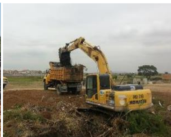
Figura 7. Pala mecánica cargando capa vegetal desbrozada del área. Fuente Elaboración Autor
