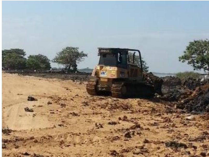
Figura 32. Tractor D6, apilando la capa vegetal del área de trabajo, para luego ser retirada Fuente Elaboración Autor
