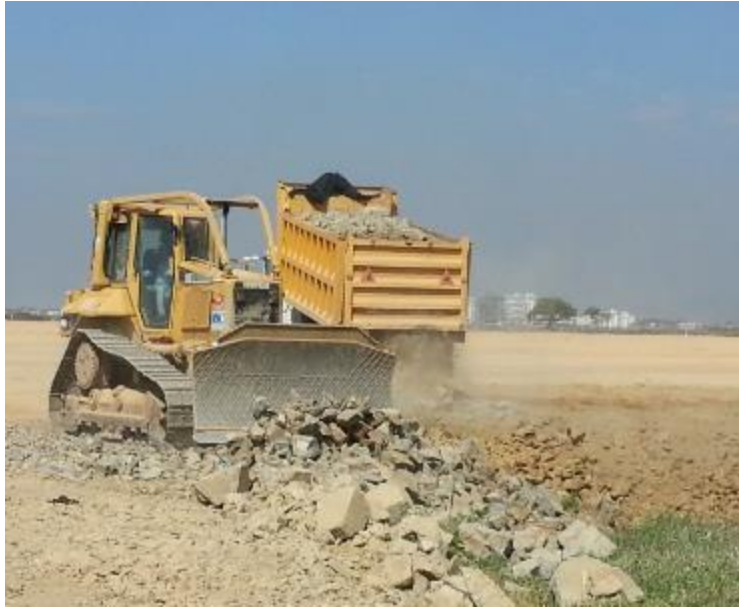
Figura 33. Descarga de material grueso (piedra gruesa) primera capa, en zonas húmedas y blandas. Fuente Elaboración Autor
