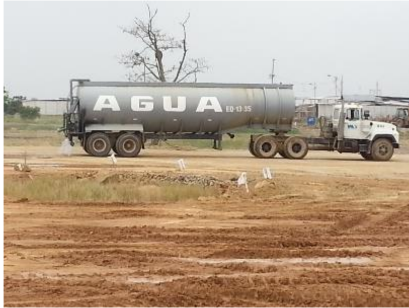
Figura 37. Hidratación de terreno, para evitar material particulado y compactación. Fuente Elaboración Autor
