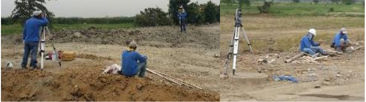
Figura 31. Equipo topográfico replanteando área de trabajo y preparando estacas para delimitar el área la etapa La Arboleda. Fuente Elaboración Autor
