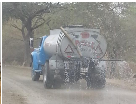
Figura 13. Hidratación de vías con el uso de tanquero con agua.
