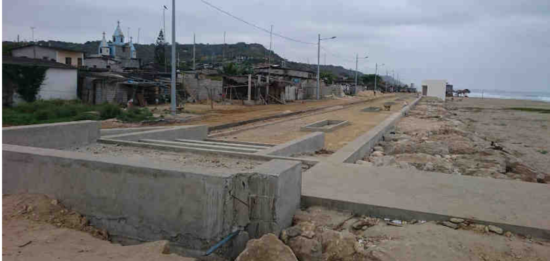
Figura 1. 4: Construcción del malecón escénico. Fuente: Autores, 2017.
