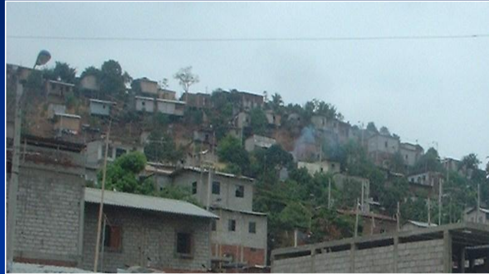
Ladera sureste del Cerro El Jordán, con viviendas de construcción mixta ubicadas en laderas sin previo estudio de factibilidad.
