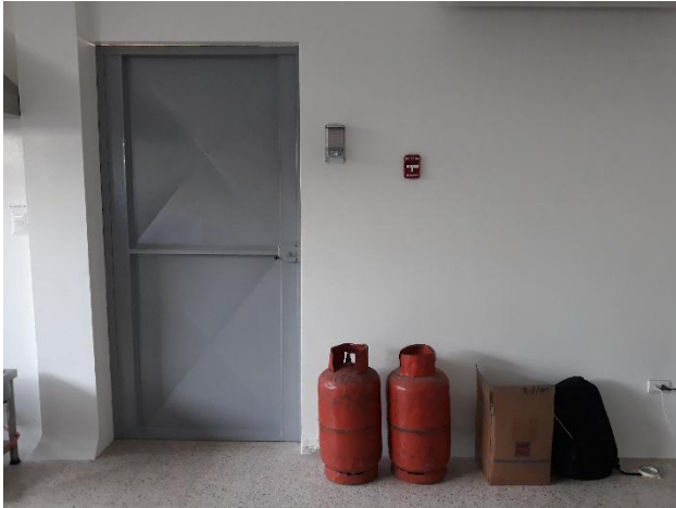
Fig. 2.2 Puerta de salida hacia el huerto Junto se localiza la perilla de aviso de incendios
