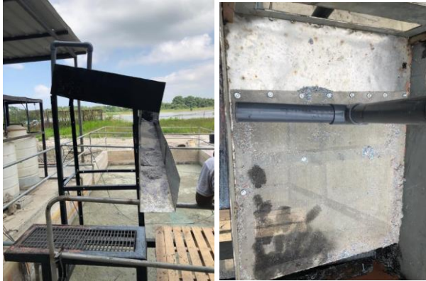
Montaje final de la nueva criba
