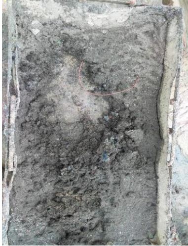
Antigua criba obsoleta
