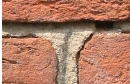
Figura 1.10 Componente usado para mantener juntos los ladrillos
