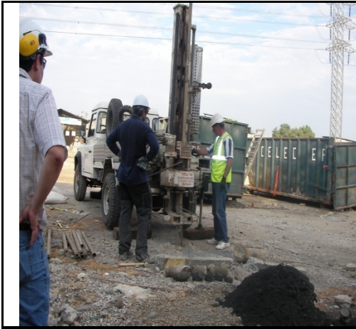
Foto de Perforación en P9
