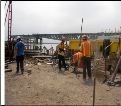
Foto de Perforación en P5
