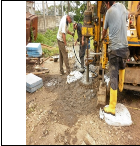
Foto de Perforación en P7
