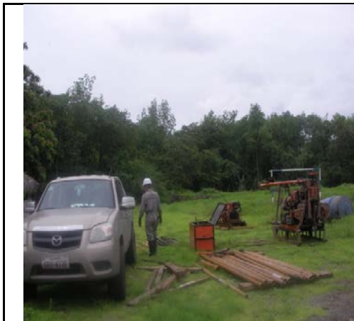
Foto de Perforación en P8
