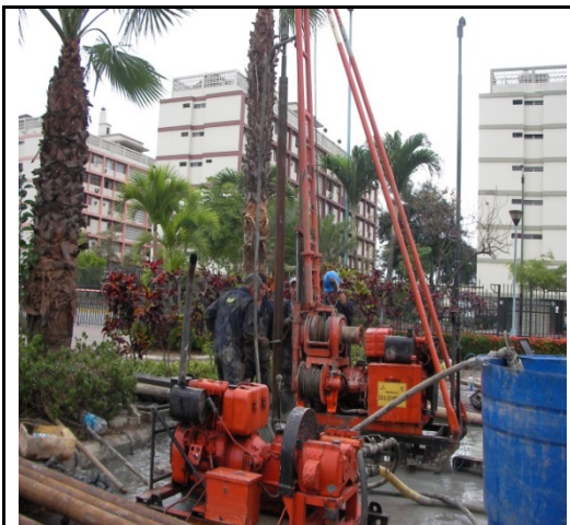
Foto de Perforación en P4
