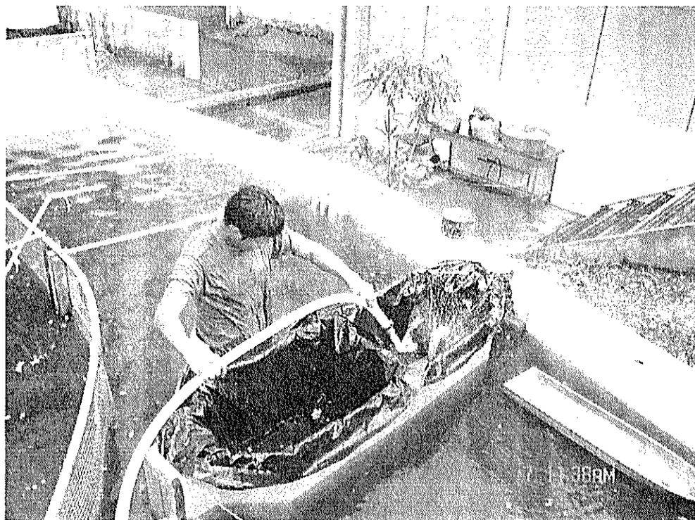
Figura No. 57 Llenado de tanques de agua de lastre
