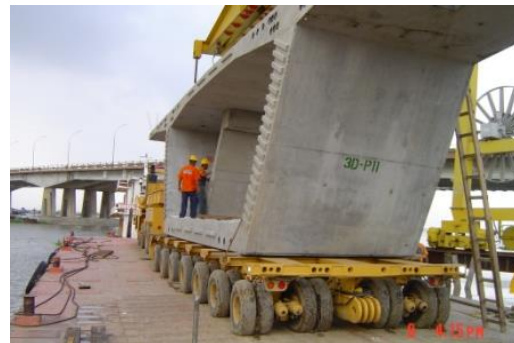
Transporte de dovela para puente Carlos Pérez Perazo
