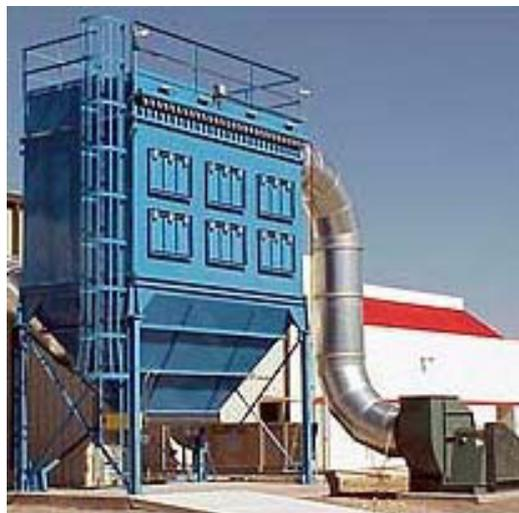
**FIGURA 3.4. COLECTOR DE POLVO TIPO BOLSA**
