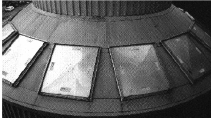
**FIGURA 4.6. PANELES DEBILES DE VENTEO**
