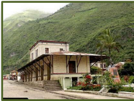
Figura 1 Estación de Tren en Alausi
