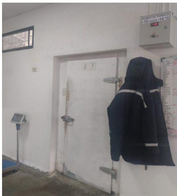
FIGURA A2- Entrada de bodega de Producto terminado
