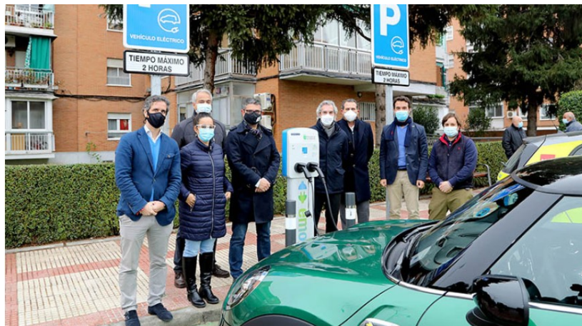
Figura 2.12 – Puntos de recarga en el zona norte de Madrid-Alcobendas. Fuente: https://movilidadeléctrica.com/puntos-de-carga-alcobendas/
