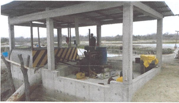
Foto 2. Inspección semestral de estación de bombeo.
