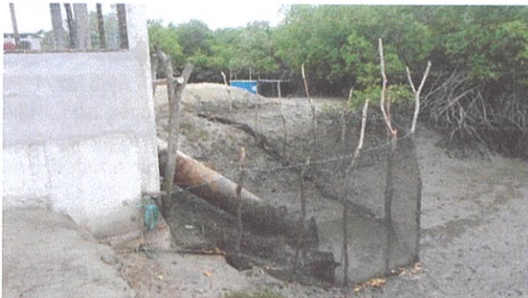
Foto 4. Inspección semestral, colocación de malla protectora en la toma de agua de la estación de bombeo.
