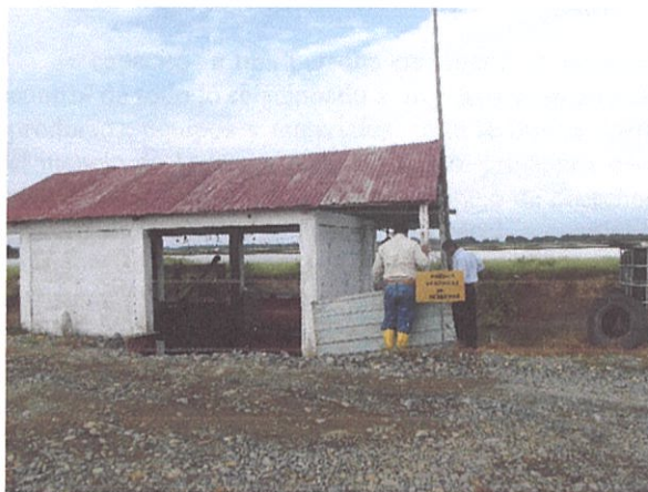
Foto 1. Inspección inicial de estación de bombeo.
