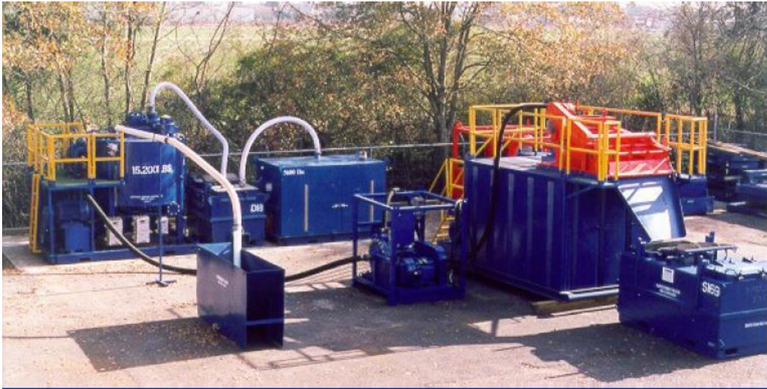
Figura 1.3. Equipo de re-inyección de rípos imagen cortesía de mi- swaco
