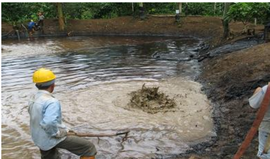
Figura 4.5. Limpieza de suelo contaminado.
