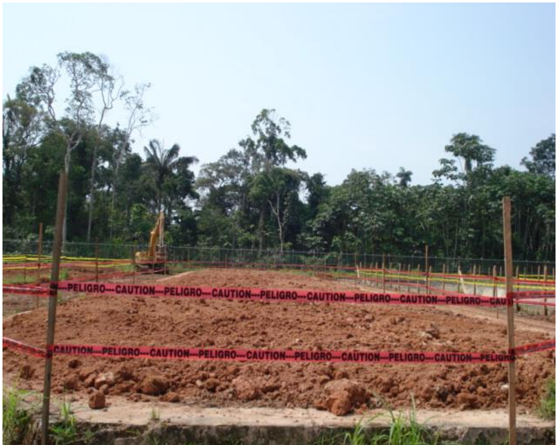
Figura 4.9. Piscina donde se entierra el material sólido de perforación
