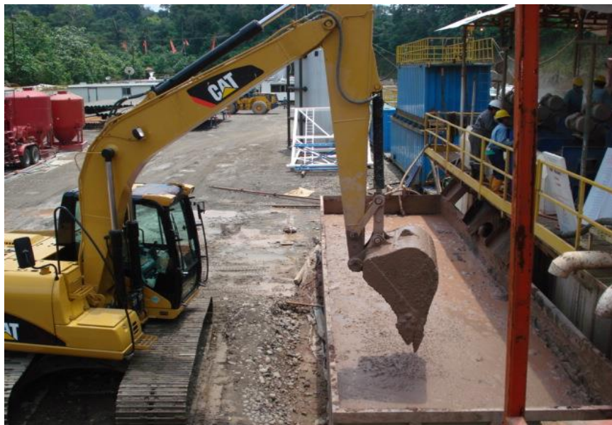
Grafico 3.13. Retroexcavadora para cargar el corte a la zona de deposición
