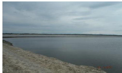
Figura 4: Piscina de engorde
