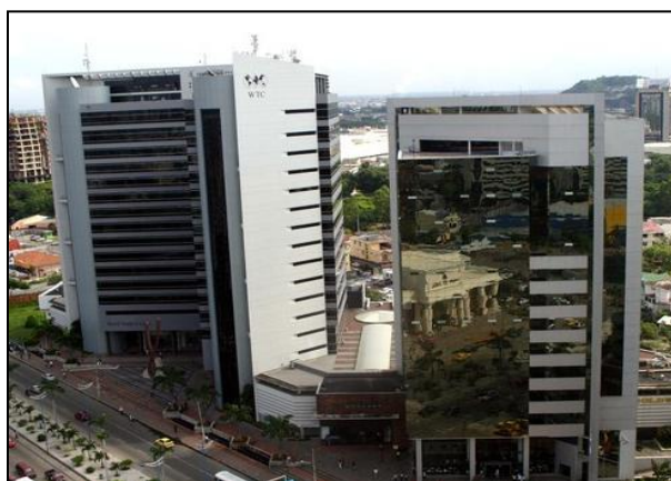
Figura 2-3: Localización Proyecto (Edificio World Trade Center) Fuente: Internet – Google Earth
