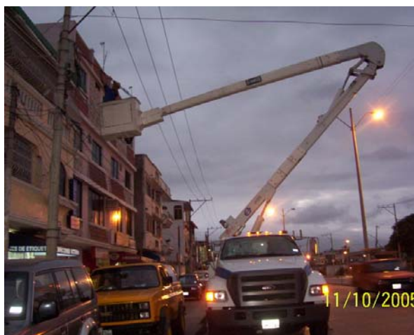
Figura 2 Instalación de los equipos PLC sobre la red eléctrica
