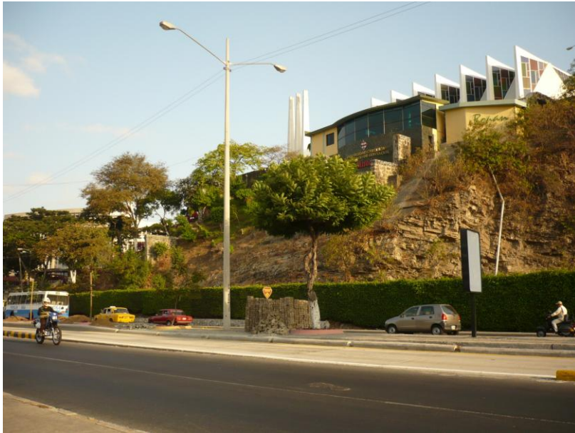
Macizo rocoso de la formación Cayo en el cual se asientan las instalaciones de la Universidad Católica.
