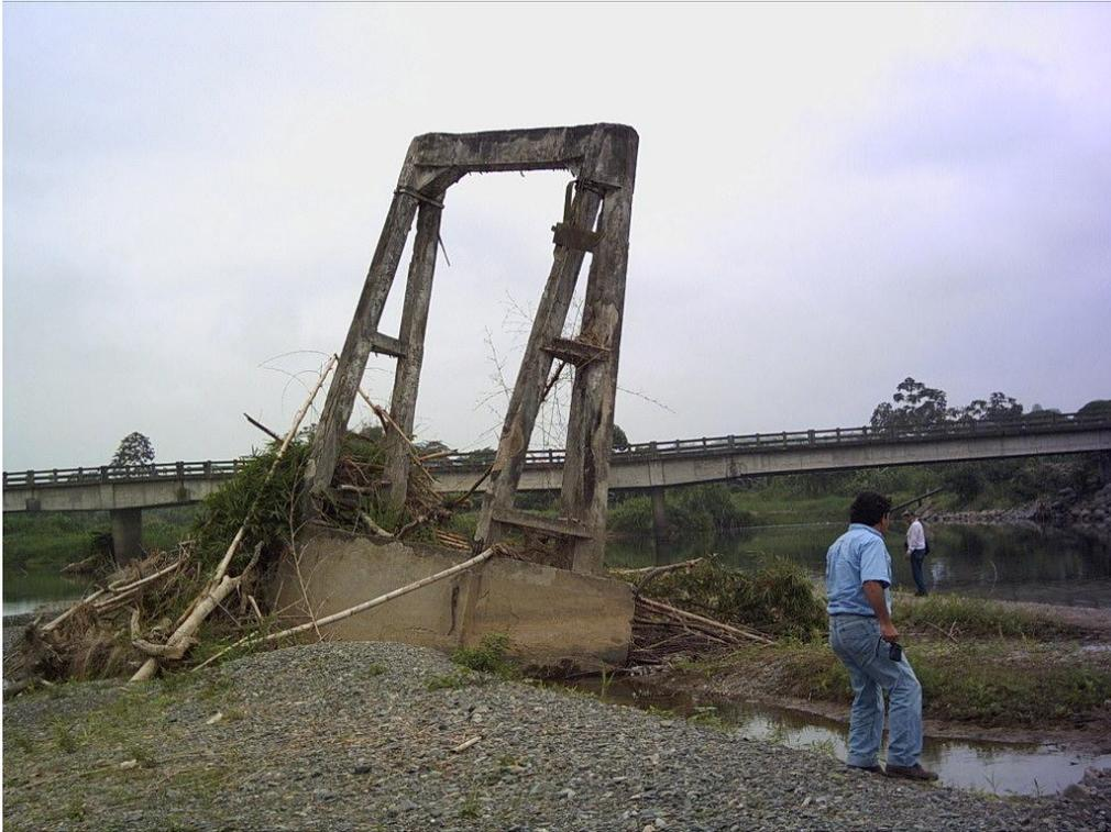
Pilas de un antiguo Puente derrumbado como producto de la erosión y personal del equipo técnico del consultor inspeccionando el lugar.
