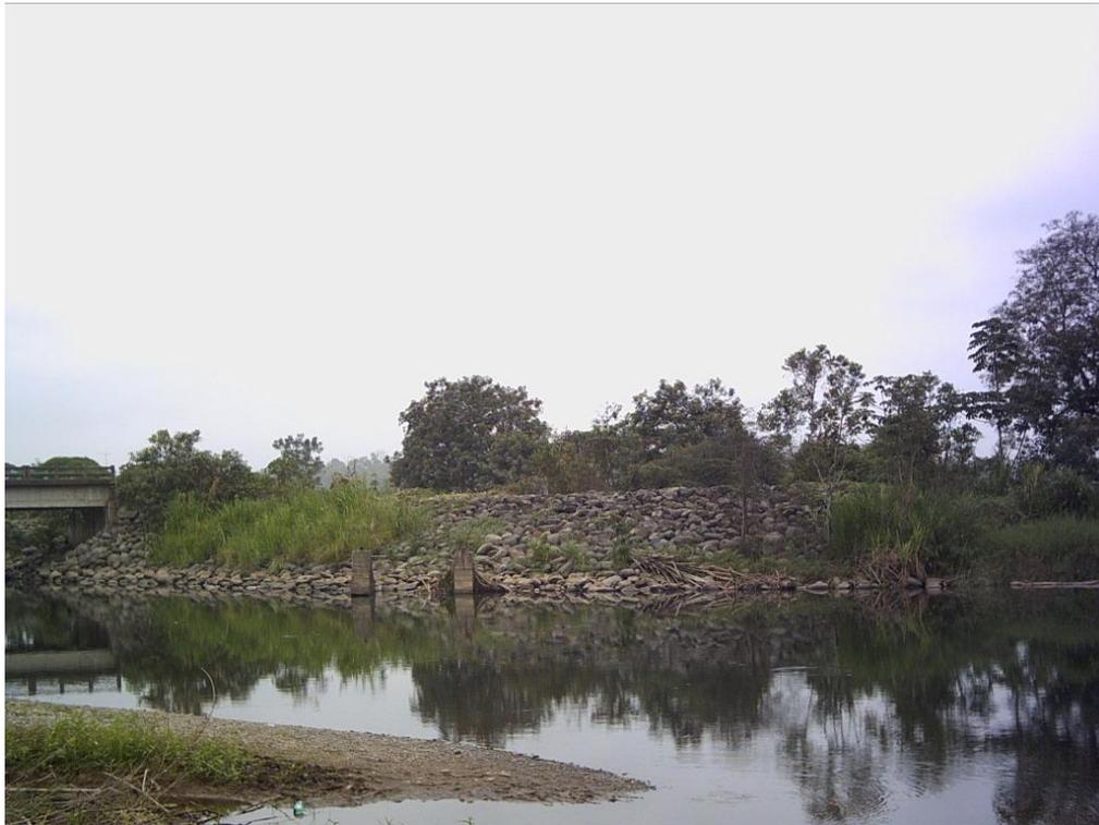
Pilas de un puente anterior que no soporto la erosión.
