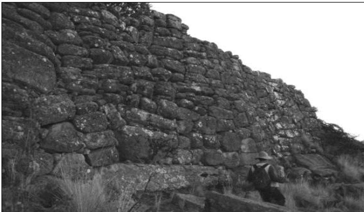
Ilustración 5.3 - Muralla alta en Lamparaquen, 2 m de altura y 1 m de ancho
