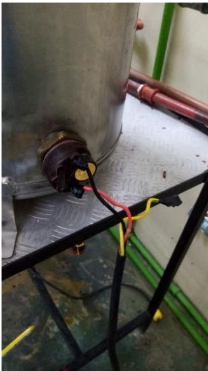
Figura 19. Instalación de Resistencia Eléctrica
