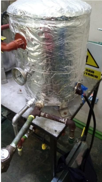
Figura 20. Instalación de aislante de fibra de vidrio
