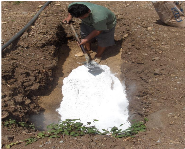
Foto 5.3.- Colocación de la cal.
