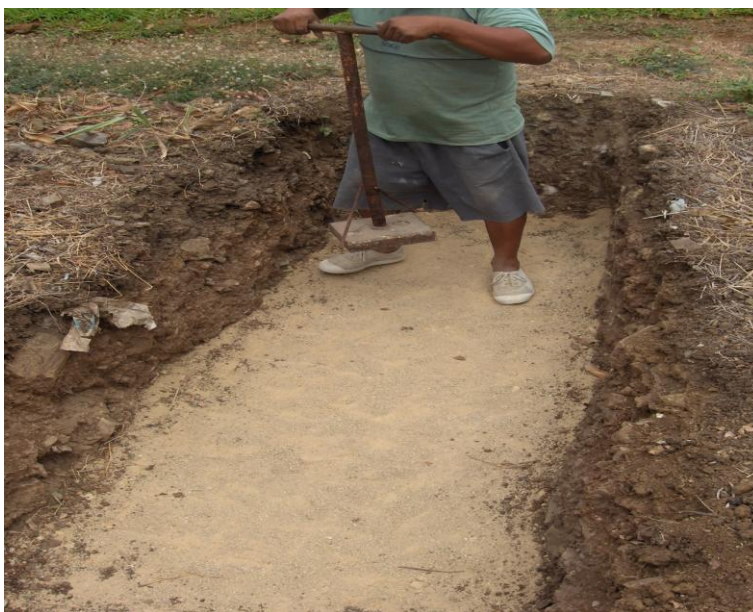
Foto 5.2.- Compactación de la arcilla.
