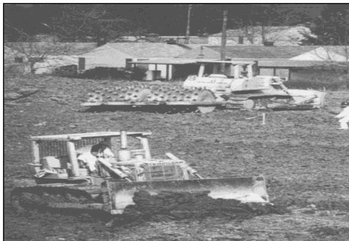
Figura 1.7.- Movimiento de tierra en Times Beach, Missouri después de detectar la presencia de Dioxina en el suelo. ( The Washington Post )
