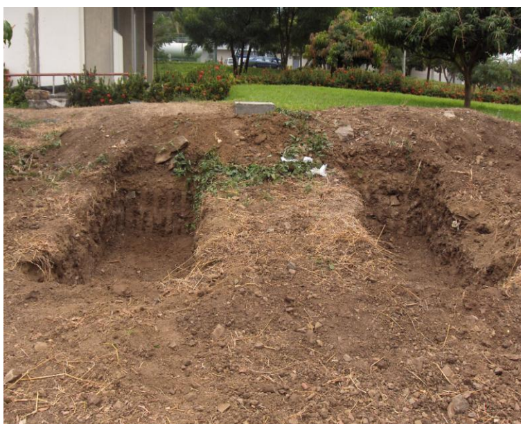
Foto 5.1.- Apertura de las zanjas
