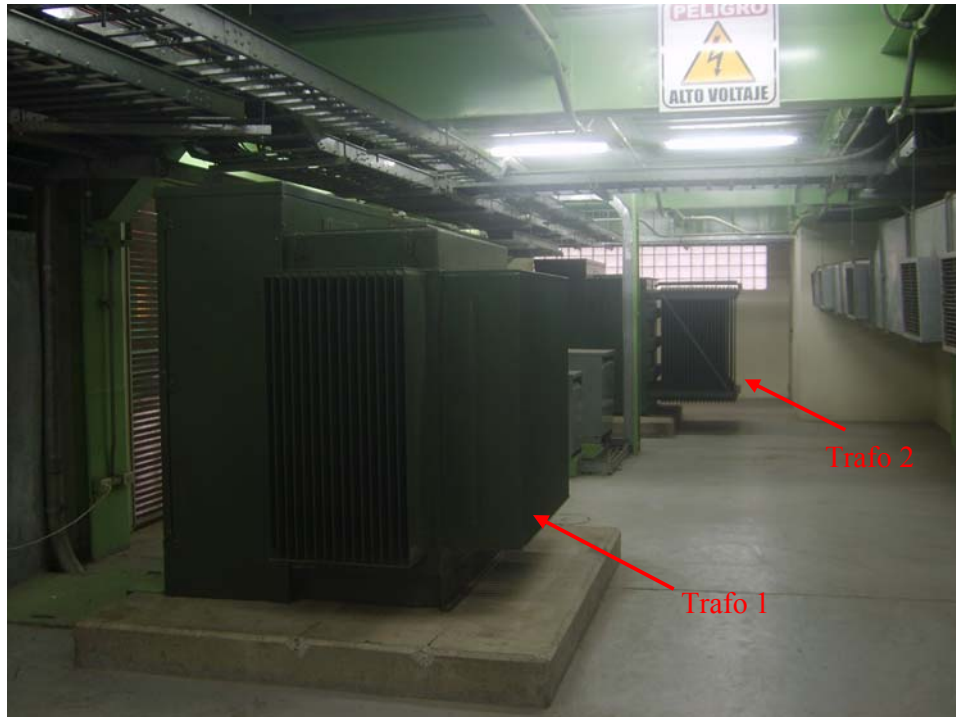
Figura 1.6 Cuarto de transformadores.
