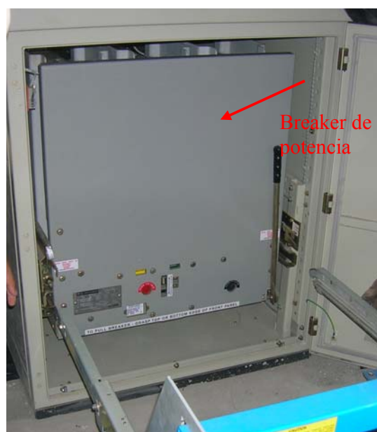
Figura 1.9 Breaker de potencia.
