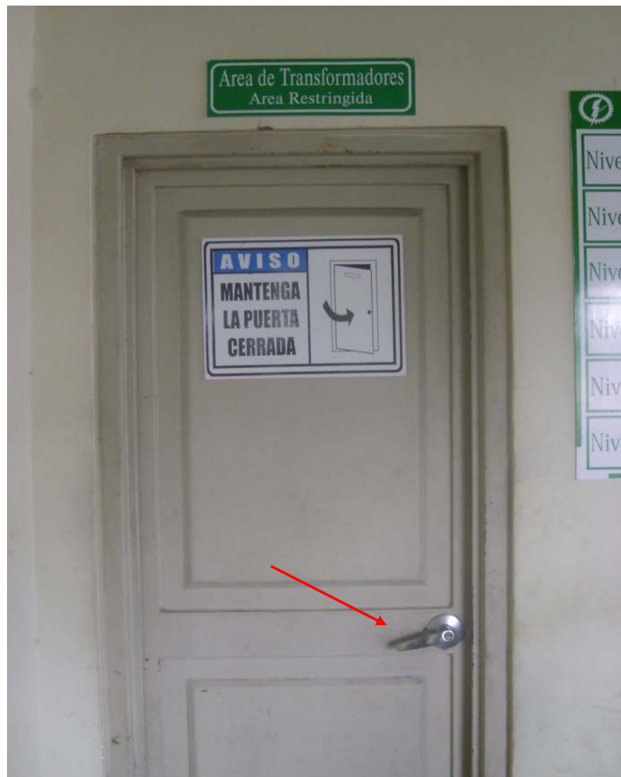
Figura 5.15 Cerraduras no adecuadas
