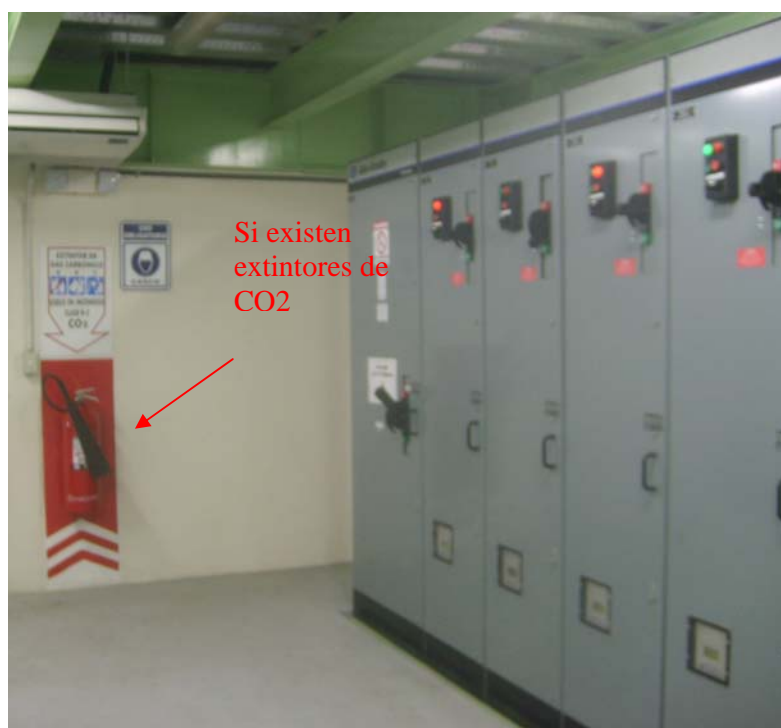
Figura 6.2 Centro de control de motores
