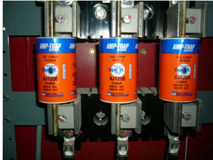
Figura 2.16 fusibles CCM casa de fuerza
