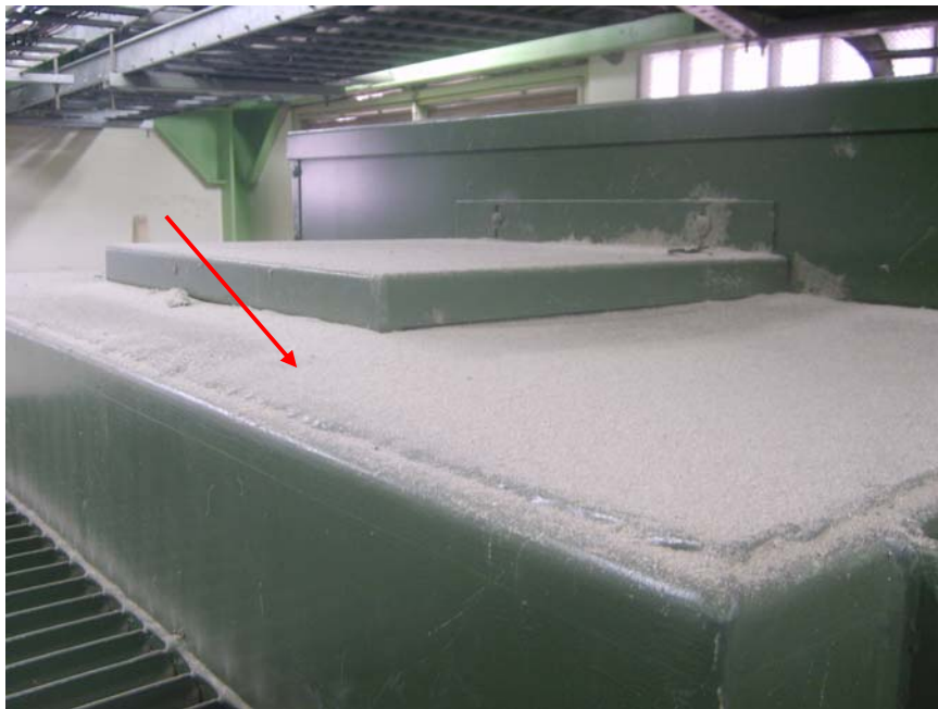
Figura 5.12 Acumulación de material sobre el transformador
