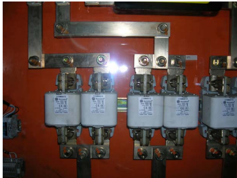
Figura 2.17 Fusible CCM Caldera
