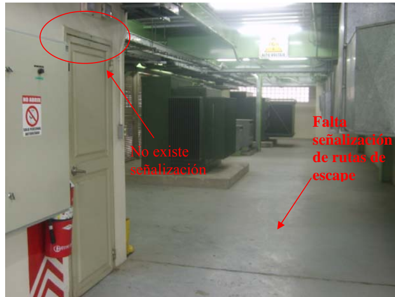
Figura 1.2 Cuarto de transformadores
